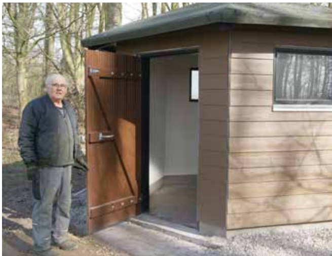
Anker Jensen viser os det nyrenoverede toilethus.
